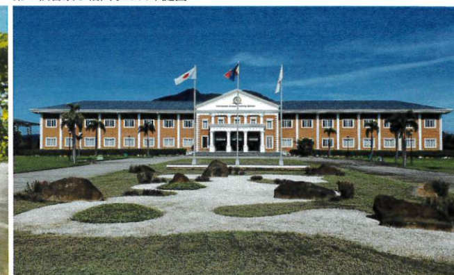
第1校舎及び枯山水の日本庭園
